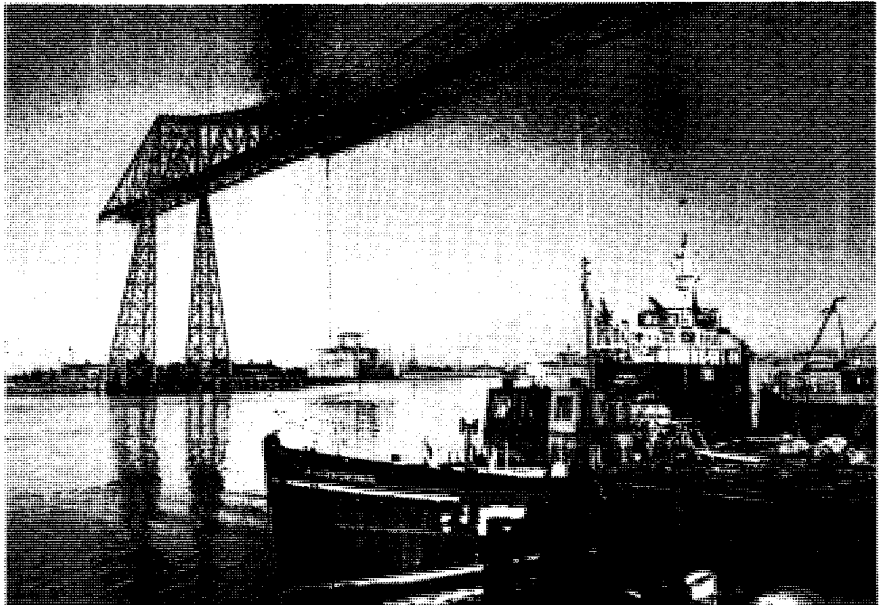
الجسر الثقيل في ميدلزبورو، بكليفلاند في إنجلترا يحمل المركبات على منصة متحركة عبر نهر التيز.
